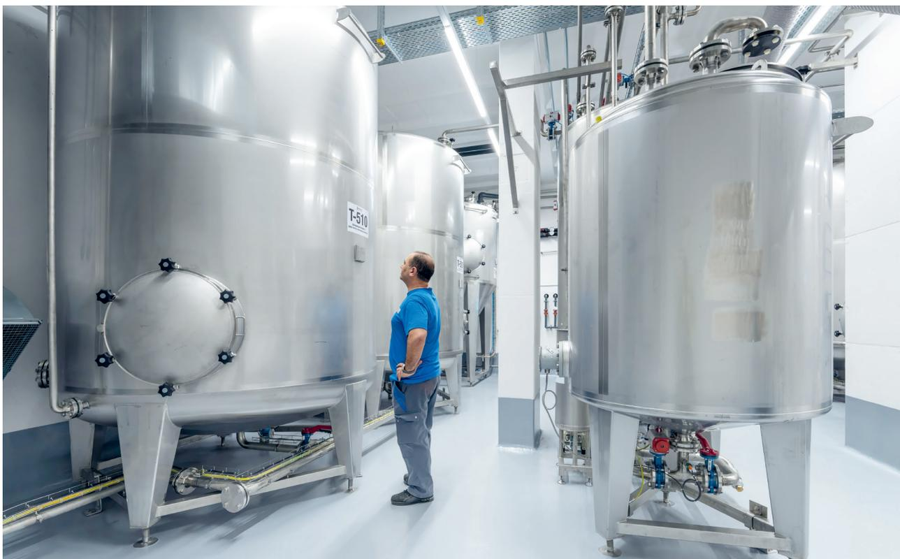
Um die Nachhaltigkeit zu verbessern und die Umweltauswirkungen der Produktion weiter zu verringern, wurde in eine neue Ultrafiltrationsanlage investiert. Es werden bis zu 2500 Liter Chemikalien pro Stunde mit einer Recyclingrate von bis zu 96% filtriert.
